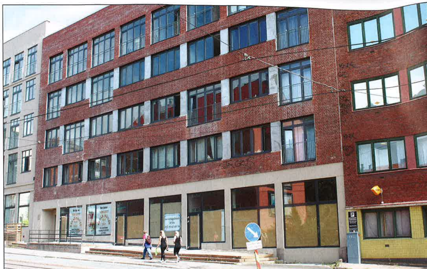
BUKKET UNDER. I boligprosjektet Rosenhoff Fabrikker i Oslo gikk mye galt. Manglende gjennomført oppkapitalisering medførte at borettslaget finansielt bukket under da utbyggeren gikk konkurs.
